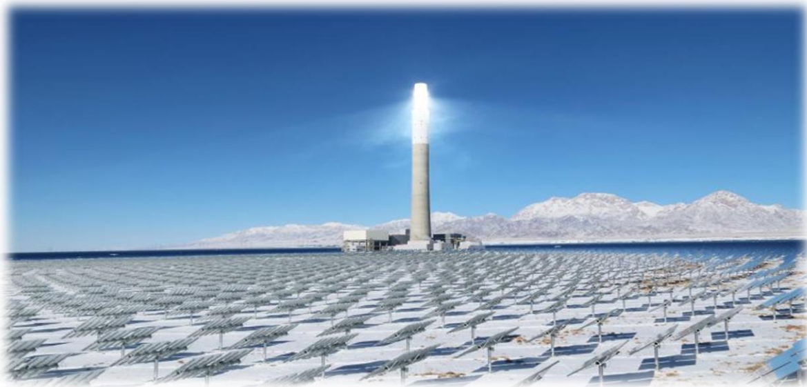
پروژه آزمایشی برج CSP در دلینگا، استان چینگهای توسط Supcon (اکنون Cosin Solar)
